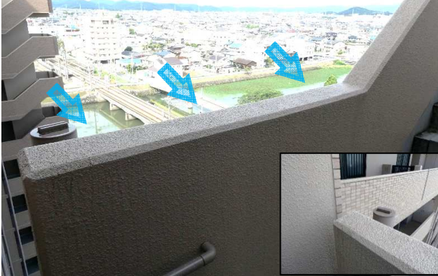
外部階段腰壁上
